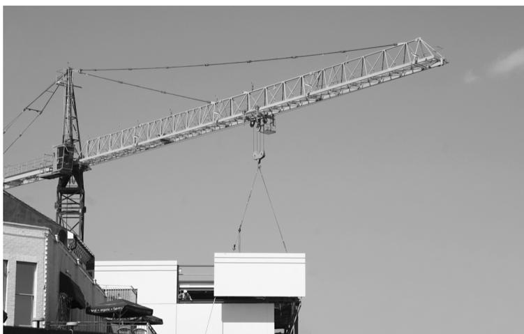
Een betonnen plaat hangt aan kabels aan de haak van een kraan.
